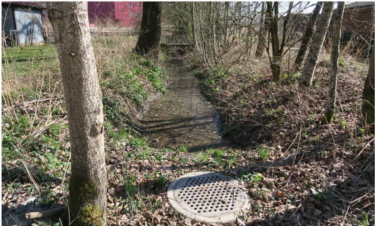
Hammergraben mit Überlaufschacht – Foto: 23.3.22 / RW
