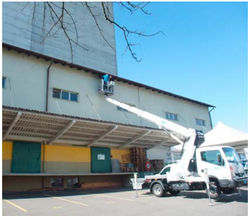
Montage der Mauersegler-Kästen mit Hilfe von Daniel Trenkle (Dominik Henseler).
