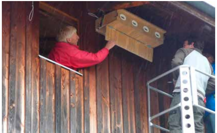
Montage der Mauerseglerkästen im Kotten mit einer Hebebühne (D. Henseler).
